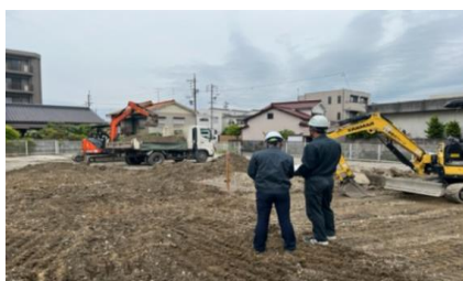
建設部門の現場作業の様子です
