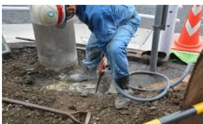
造成や解体など様々な現場があります
